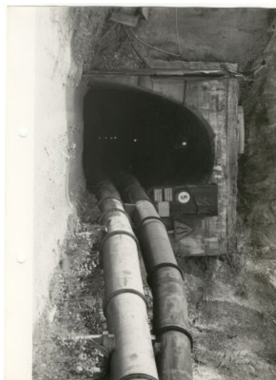
Budowa elektrowni pompowo-szczytowej w Młotach
