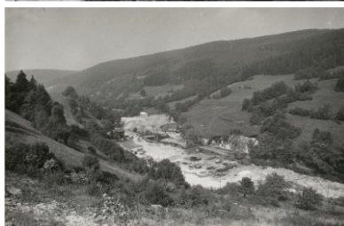
Budowa elektrowni pompowo-szczytowej w Młotach
