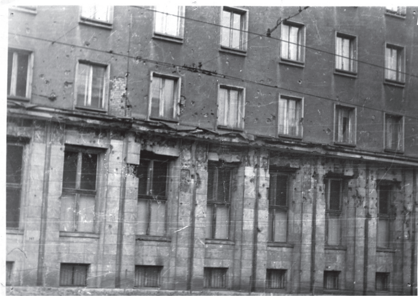
Fot. 13. Widok budynku Archiwum Państwowego we Wrocławiu z lat 40. XX w. od strony ul. Pomorskiej.
