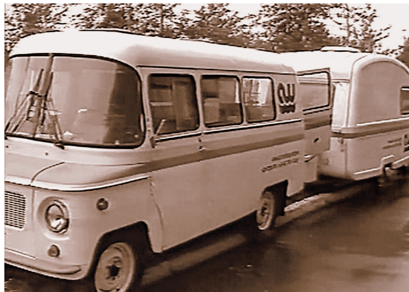
22. Mikrolaboratorium mobilne AW-11 do badania wód, fot. z 1988 r.
