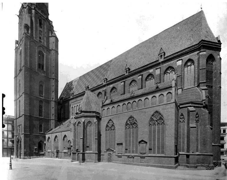
Fot. 4. Kościół widoczny od strony południowo-wschodniej. Fotografia z lat 20-tych XX w. APWr., Zbiór Ikonograficzny, sygn. 767.
