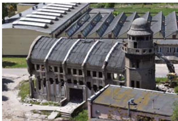
Rozbiórka obiektu składowego nieczynnego zakładu Bonitex S.A. Autor zdjęcia Dariusz Gołębiewski. Data wykonania 21.05.2020 roku.
