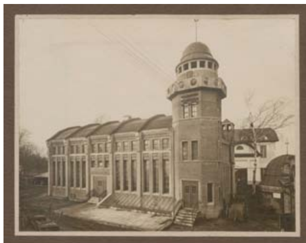
Hala elektrowni wodnej przy zakładach Concordia w Bolesławcu Sygn. arch. 86/378/0/-19.
