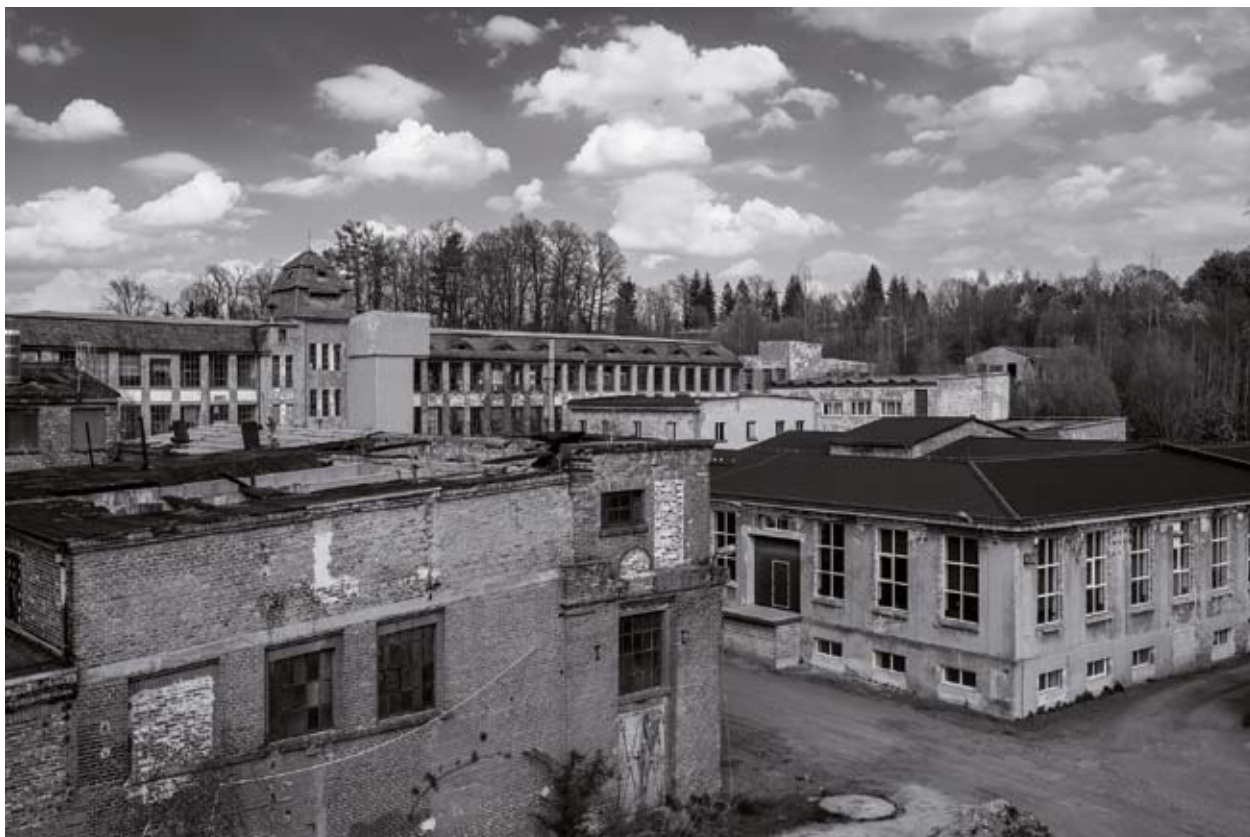
Dawne zakłady „Dolwis” w Leśnej. Autor zdjęcia Rafał Klimek. Data wykonania 02.05.2022 roku.
