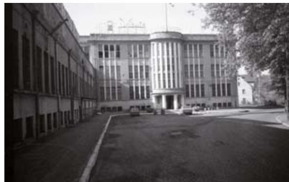
Zakład Przemysłu Jedwabniczego "Dolwis" w Leśnej. Budynek biurowy. https://www.dbc.wroc.pl/dlibra Zdjęcie wykonane w maju 1986 roku
